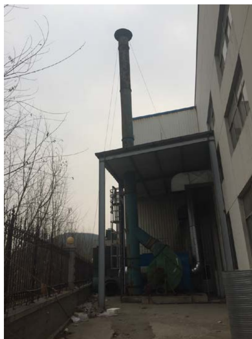
图 3-2 焊接、打磨排气筒
